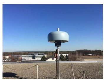
FIGURE 18: INSTALLATION OF IZT R5506 RADIO DIREC-TION FINDER
